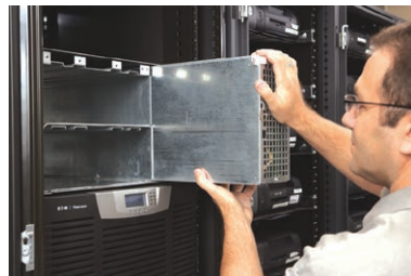
簡単なエレクトロニクスモジュールの設置
